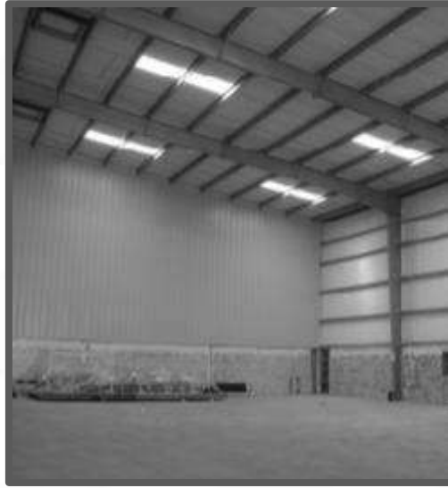
شكل رقم (2) يوضح أسلوب بناء الحوائط من البلوك بارتفاع مترين على الأقل من سطح الأرض
