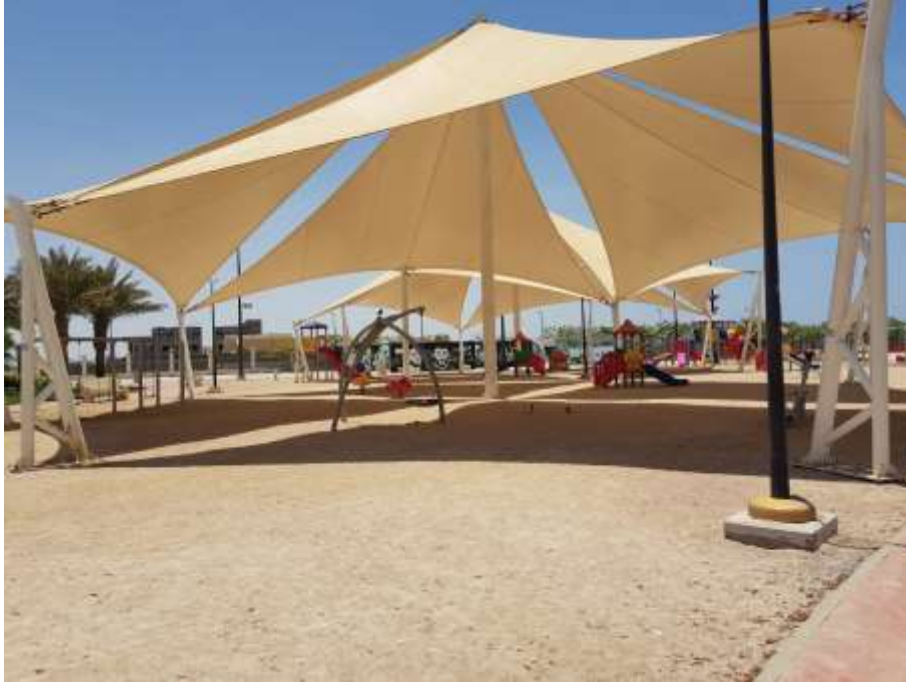
صورة لمنطقة ألعاب الأطفال القائمة علما بأنها بحاجة الى ترميم
